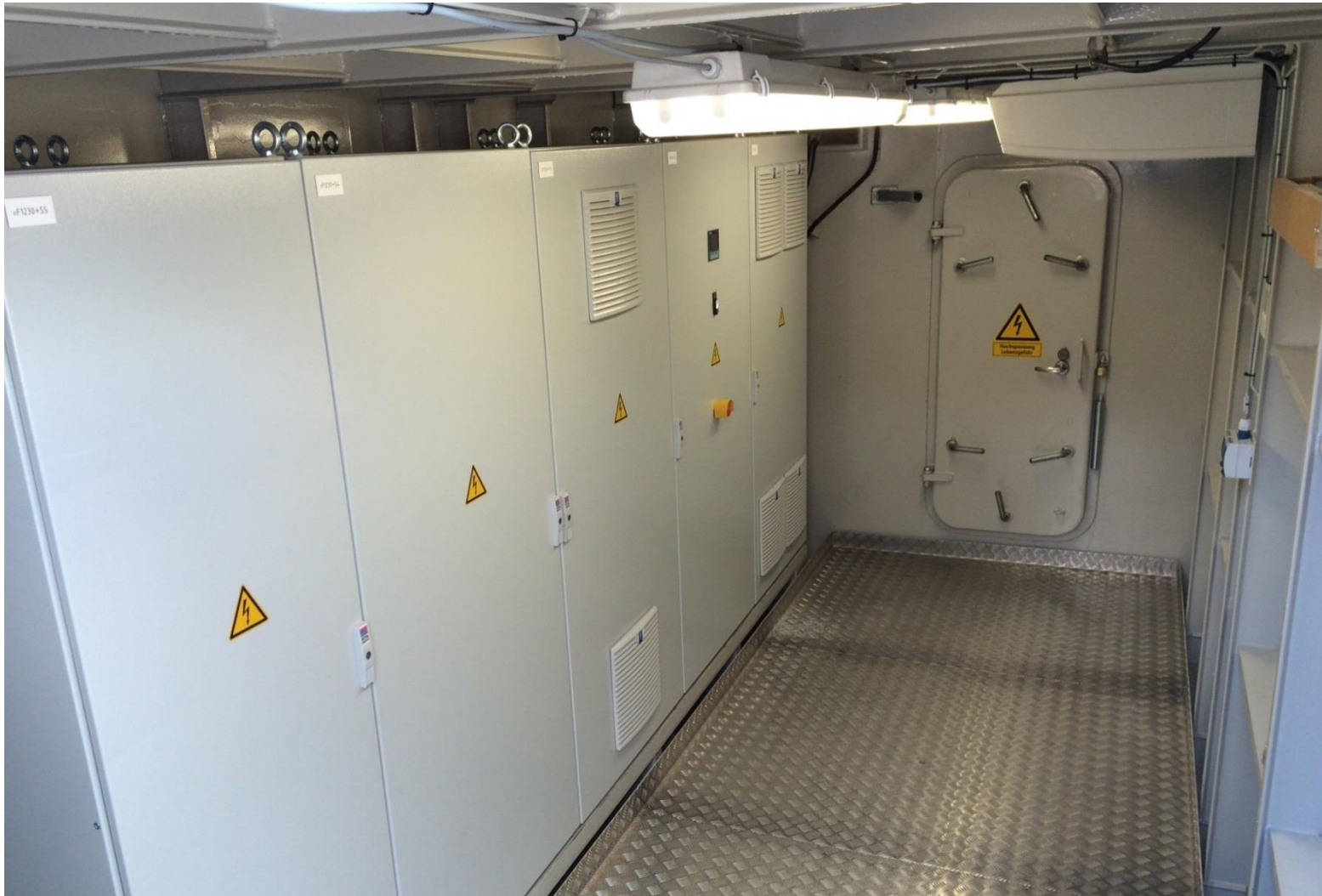
Abb. 15-2: Elektro-Ponton (Backbord) – geschlossene Bauweise
